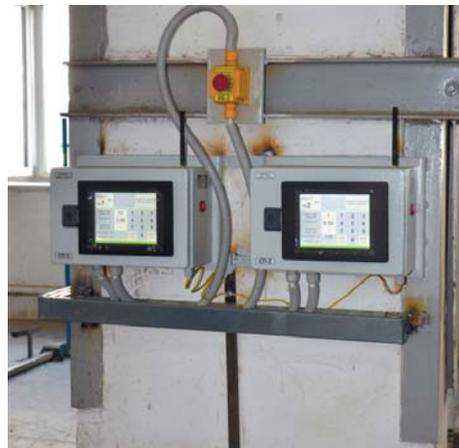
Посредством беспроводной Wi-Fi связи посты заказа бетонной смеси интегрируются с системой АСУ БСУ. Таким образом, процесс производства бетонной смеси может быть инициирован непосредственно с поста заказа АТК АДБ и после прохождения всех проверок, обусловленных логикой работы АСУ БСУ и АСУ АДБ, без участия оператора БСУ, при наличии соответствующих разрешений запущен на исполнение на БСУ в автоматическом режиме, после чего отгружен и доставлен.
